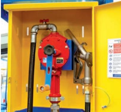
Allestimento standard con pompa da 40 l/min e pistola manuale.
