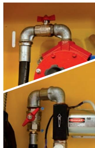
I rubinetti di sicurezza tra la pompa e la pistola. Safety cocks between the pump and the nozzle.
